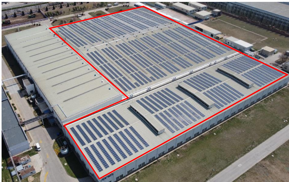
今回導入したメガソーラー。工場の屋上（赤枠）にソーラーパネルを設置
